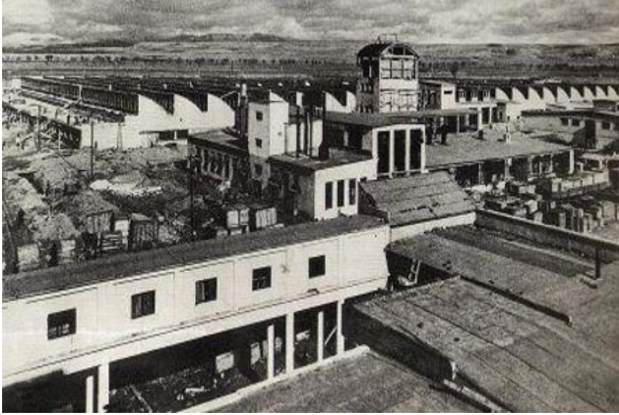
Temeli 20 Mayıs 1934'te Başbakan İnönü Tarafından Atılan ve 16 Eylül 1935'te İşletmeye Açılan Kayseri Bez Fabrikası
